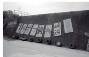
崎浜地区の堤防
