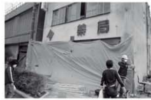
ビニールシートの貼り直し作業
