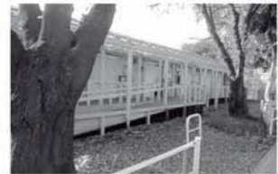
障がい者用の仮設住宅
