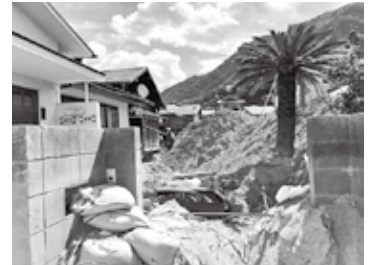
(写3)土砂に埋もれた家屋
